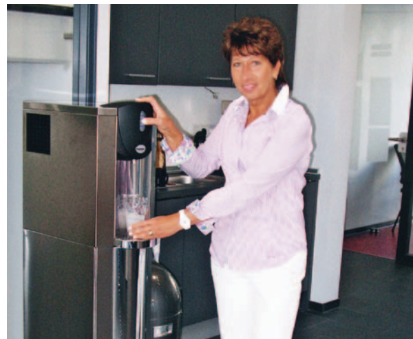
Bild: Tafelwasseranlage im Verwaltungsgebäude SWA
